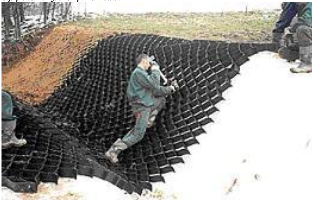
Rys. nr 2 Układanie geokomórek.
