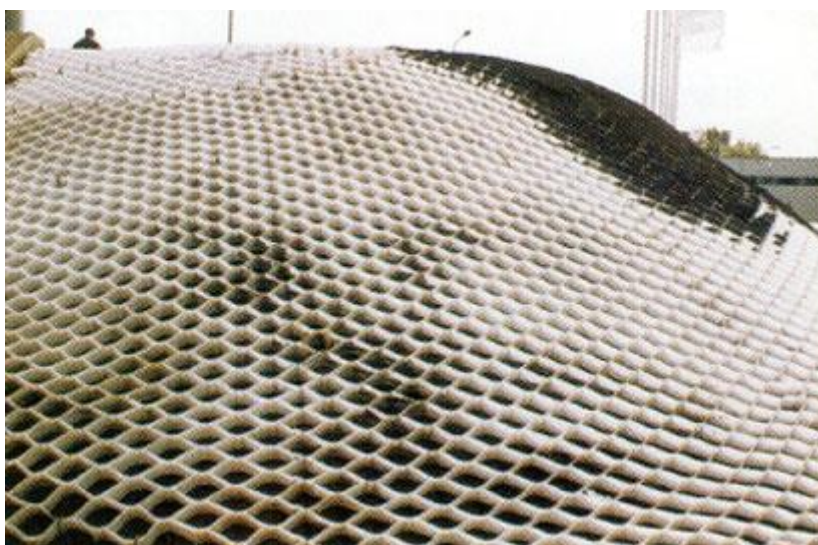
Rys. nr 4 Zasypywanie humusem.
